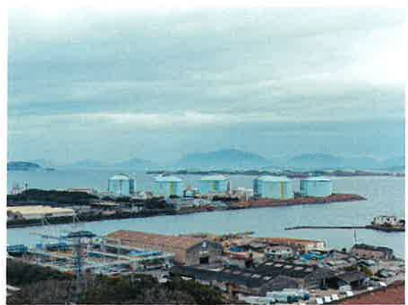
液化天然ガス貯蔵設備
